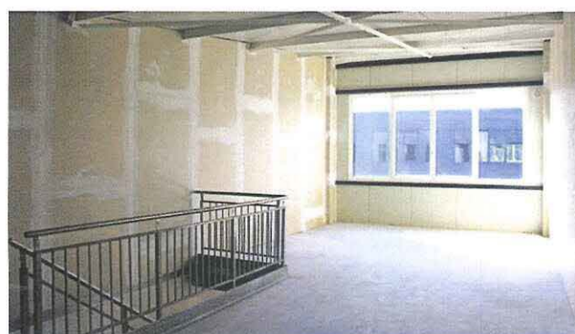
Malgré l'ouverture pour l'escalier, plus de 40 m 2 à l'étage.
